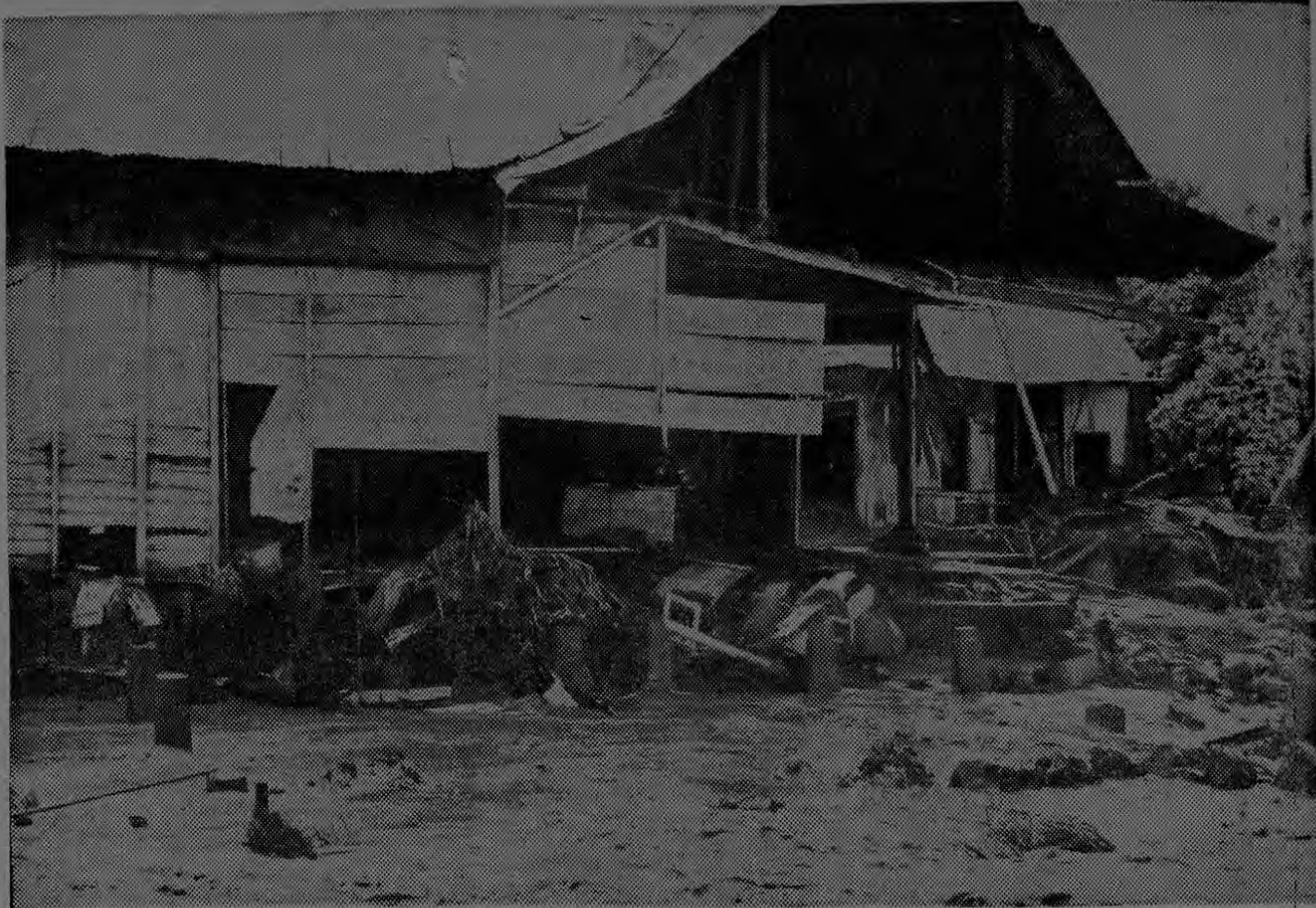
LA FOTO NO PUEDE ser más elocuente, porque traduce la desolación y la ruina que las inundaciones han causado en la zona Atlántica y en el cantón de Turrialba. Una casa semi-
