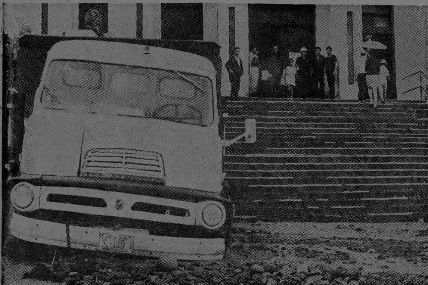
VEHICULO ATASCADO. — Así quedó el pesado camión que llegó a La Suiza de Turrialba a brindar transporte a cientos de personas que se encuentran aisladas en uno de los pocos edificios que quedan en pie; la Iglesia del lugar. Las fuertes co-
