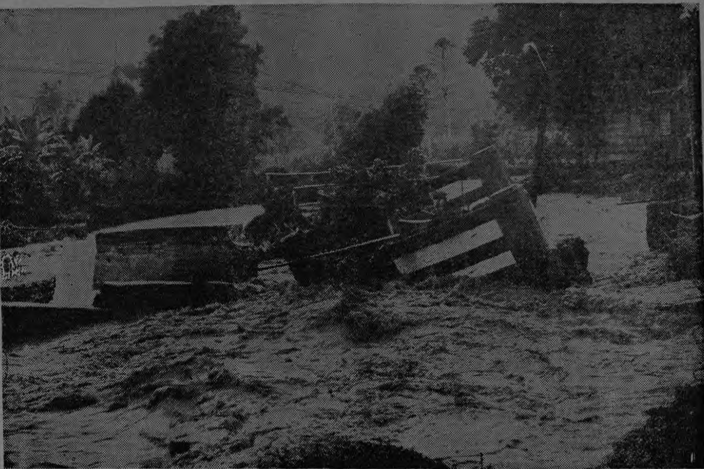
EN ESTA GRAFICA puede observarse con toda claridad la fuerza de la naturaleza, al ver cómo quedó el puente que unía Turrialba con La Suiza, totalmente destruido. A la derecha puede verse a varios vecinos. (Foto Córdoba).
